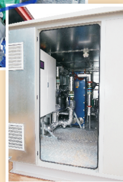
El espacio en planta innovador e integral del EnviroTech, que contiene bombas del sistema, intercambiador de calor de placas, recarga de anticongelante, válvulas del sistema, calderas y controles.
