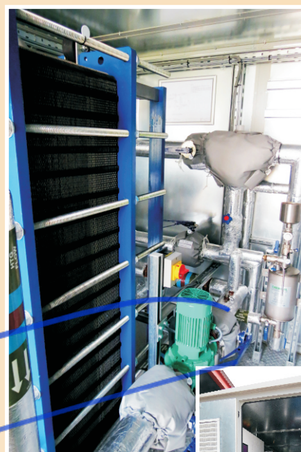
El espacio en planta innovador e integral del EnviroTech, que contiene bombas del sistema, intercambiador de calor de placas, recarga de anticongelante, válvulas del sistema, calderas y controles.
